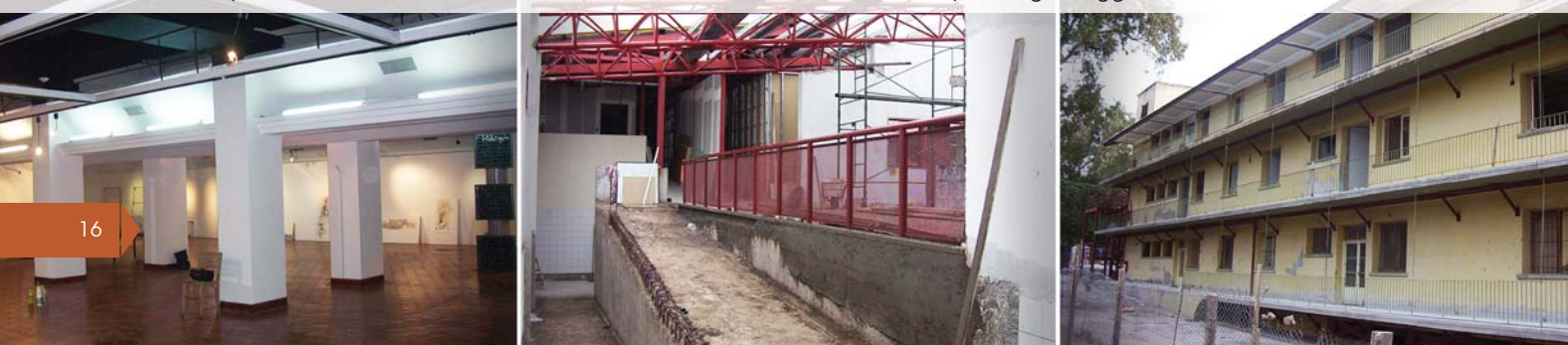
Aditorías de obras públicas. Museo de Arte Moderno. Centro de Salud Estanzuela. Hospital Lagomaggiore
